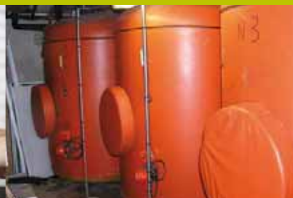
Maîtriser le risque lié aux légionelles nécessite de bien connaître le mode de production d'eau chaude.
