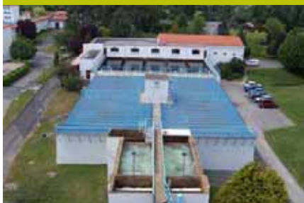
Station de traitement d'eau potable.
